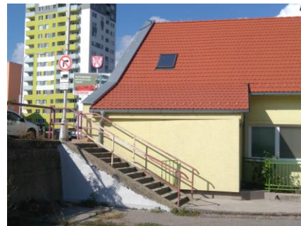
Juhozápadná strana pozemku za schodiskom
